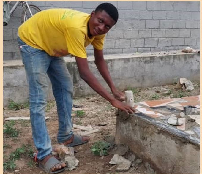
Luis legt Fliesen. Luis lays tiles.
